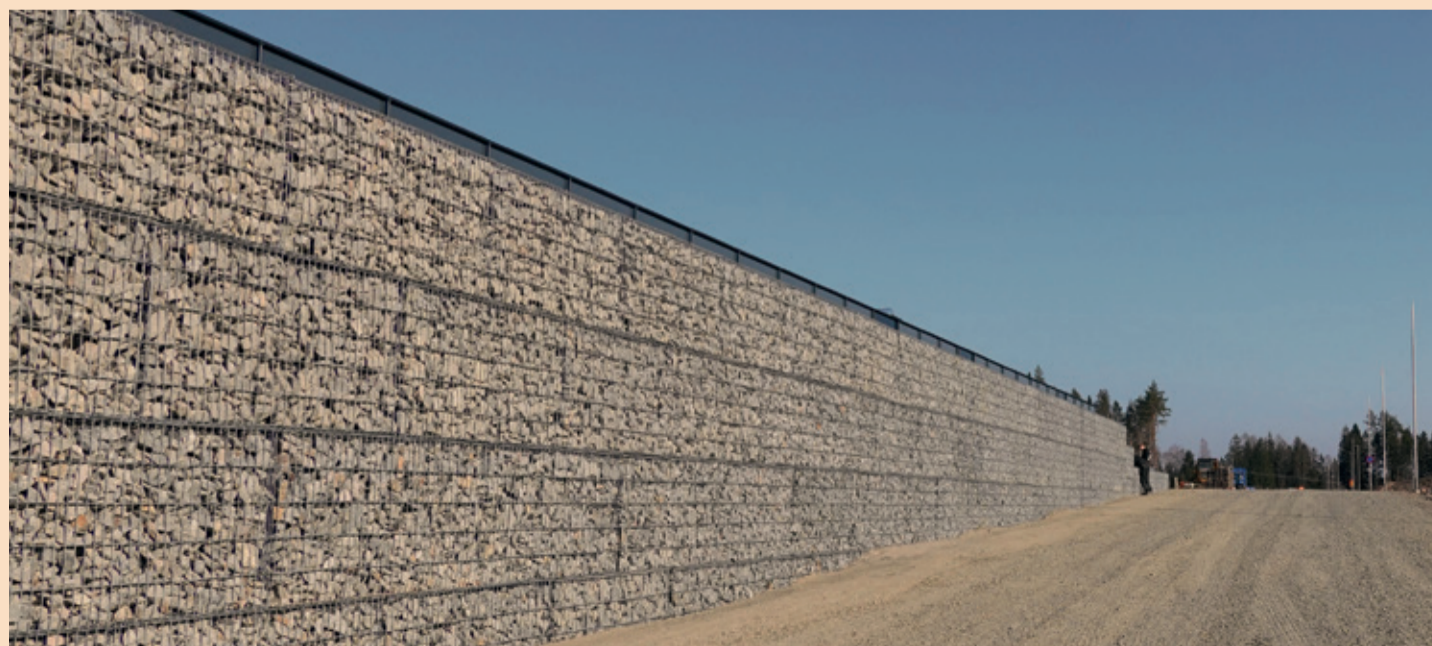
Muro di gabbioni ledro steel box in Svezia
